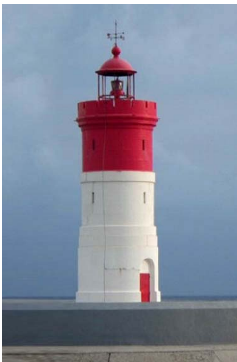
Dique de Navidad Light
